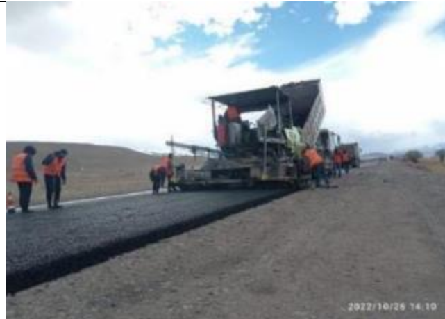
Фото 75. Лот 2. Устройство ЩМА км 81+675-82+000 RHS
