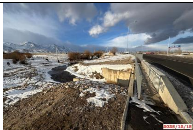
Фото 33. Лот 2. Мост км 86+261. р. Саздын-Суусу, объездная дорога, после рекультивации, в зимний период. Декабрь 2025 г.
