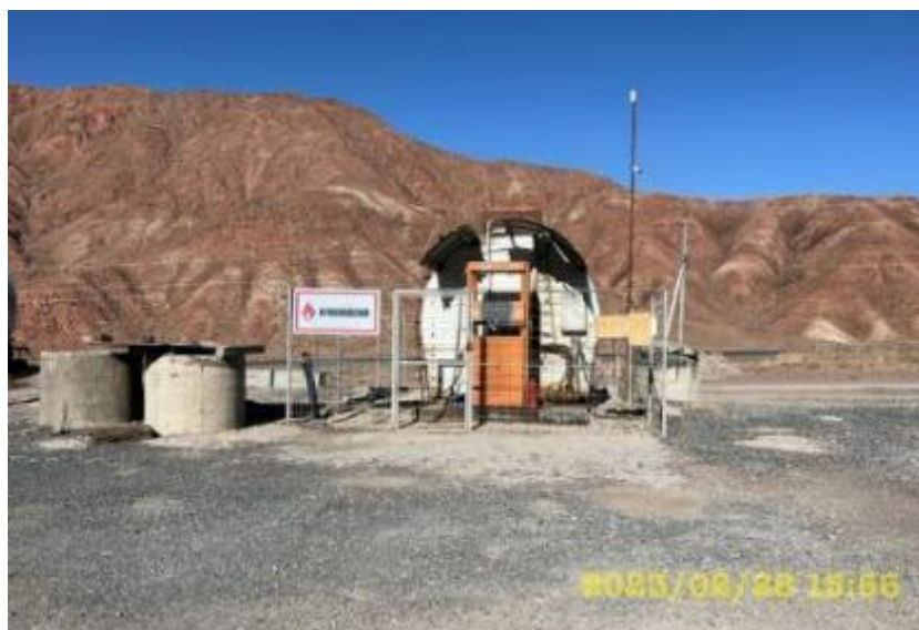
Фото 118. Лот 1. Санитарное состояние территории АЗС
