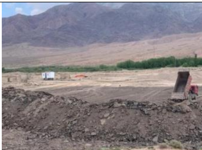
Фото 45. Размещение старого асфальтобетона на км. 7+100. Июль 2021 г.
