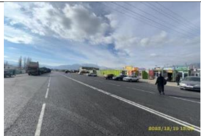
Фото 79. Лот 1. Трасса дороги с новым асфальтовым покрытием
