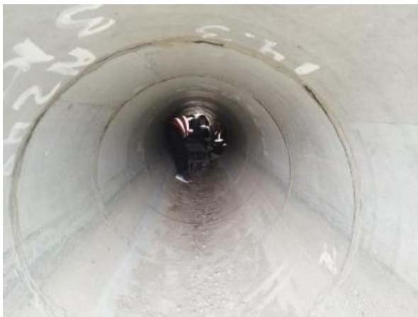
Фото 3, 4. Лот 1. Очистка водопропускных труб. Июль 2025 г.
