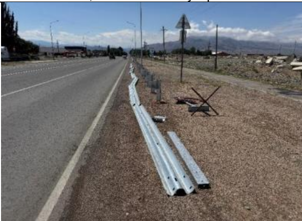
Фото 7, 8. Лот 1. Устройство барьерных ограждений Июль 2025 г.
