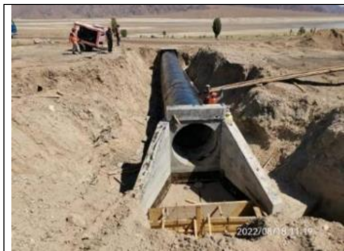
Фото 97. Лот 1. Завершено установка и гидроизоляция водопропускной трубы на 37+161
