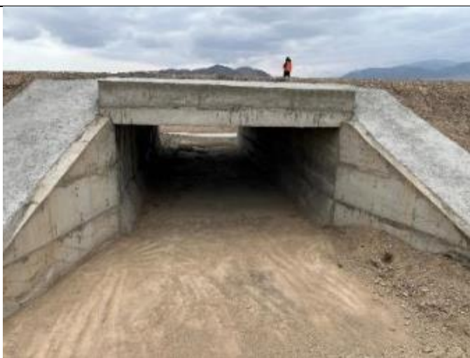
Фото 103. Лот 1, км 22+575, очистка водопропускной трубы.
