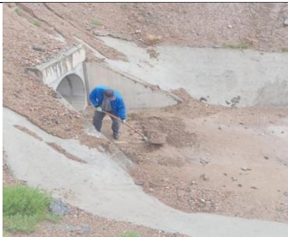
Фото 3, 4. Лот 1. Очистка водопропускных труб. Июль 2025 г.
