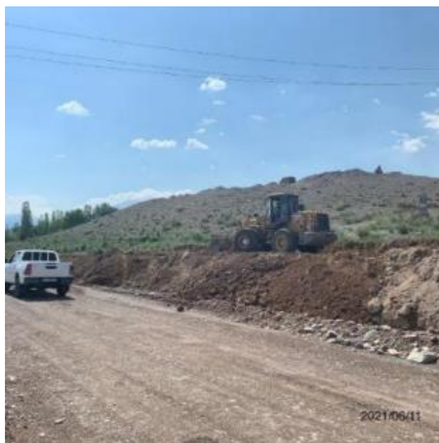
Фото 14. Лот 2. Снятие ПРС с участка под карьер
