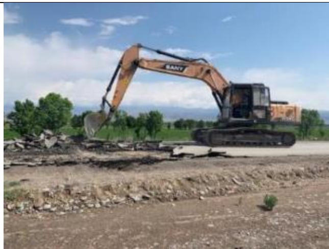
Фото 50. Вскировка асфальтобетонного покрытия на км. 74+550
