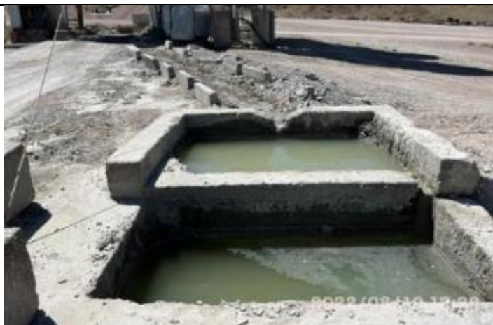
Фото 115. Лот 1. 3-х камерный резервуар первичной очистки сточных вод БСУ
