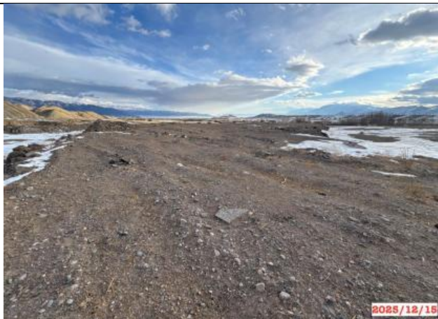
Фото 30. Лот 2. Отвал старого асфальта на км. 89+093 после его рекультивации, в зимний период. Декабрь 2025 г.
