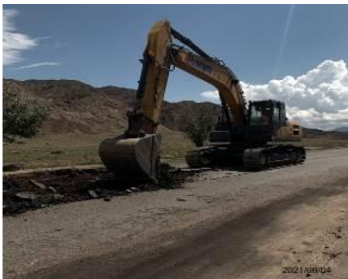
Фото 41. Вскирковка старого асфальта на км. 17+500
