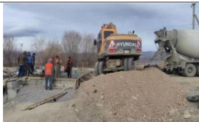
Фото 89. Заливка бетона переходной плиты 1 км 68+044
