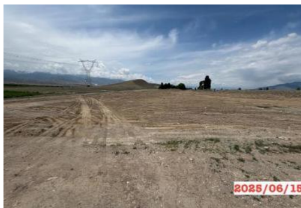
Фото 23. Отвал старого асфальта на км. 70+180 LHS после рекультивации
