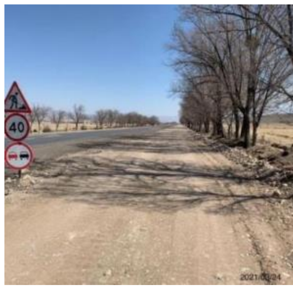
Фото 19 и 20. Обочины дороги с удаленным почвенным слоем
