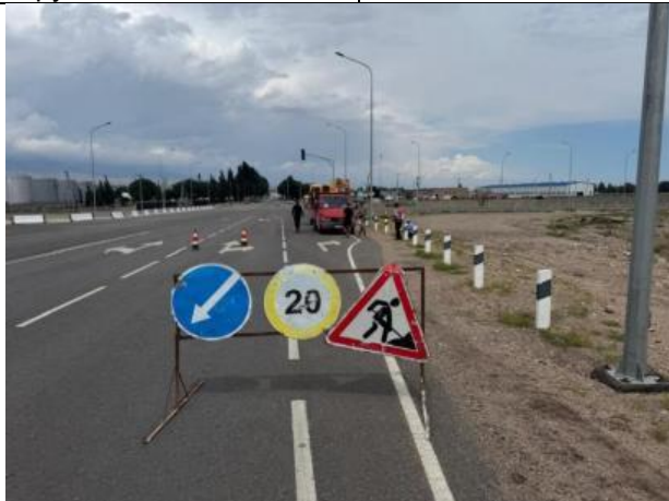
Фото 11. Демонтаж сигнальных столбиков для устройства барьерного ограждения. Август 2025 г.
