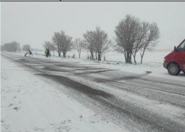
Фото 18, 19. Лот 2. Подсыпка инертного материала
