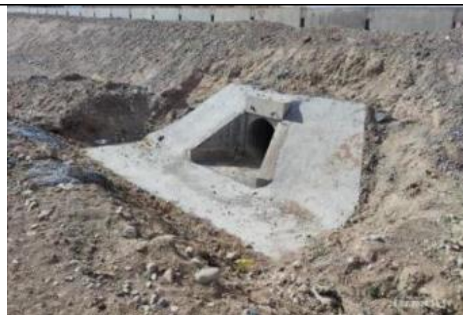
Фото 105. Лот 2. Строительство укрепления на входе трубы, км.88+692
