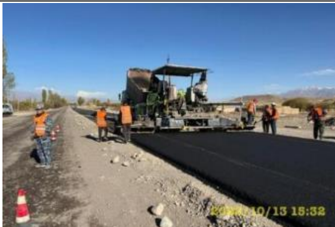
Фото 74. Лот 2. Укладка биндер слоя км 87+100
