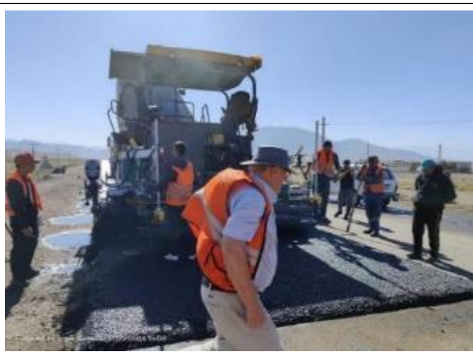
Фото 77. Лот 1. Укладка ЩМА с 3+140 LHS
