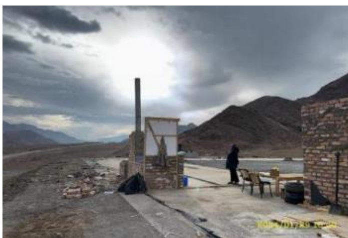
Фото 129. Лот 1. Лагерь в процессе завершения демонтажа. Январь
