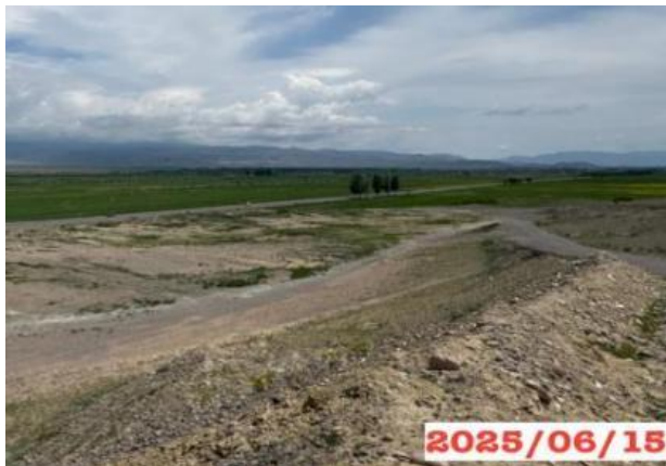
Фото 26. Отвал непригодного грунта на км.80+900, после рекультивации
