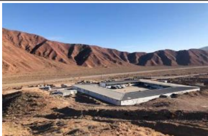
Фото 119. Лот 1. Общий вид лагеря Лот 1 км 16 + 100 (RS).
