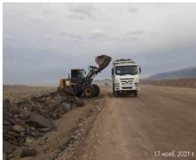
Фото 42. Вскирковка и вывоз старого асфальта на км. 28+200-28+700
