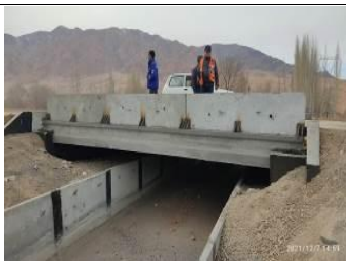
Фото 87. Лот 1. Строительство моста завершено
