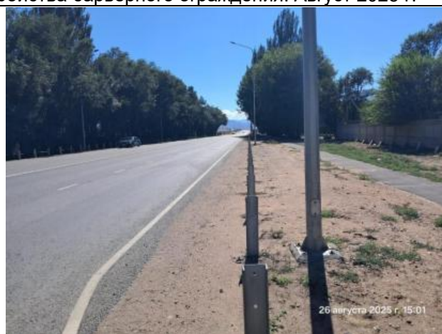
Фото 12, 13. Лот 1. Установка дополнительного ограждения для уличного освещения. Август 2025 г.
