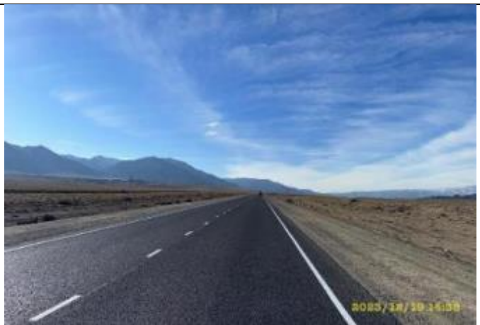
Фото 78. Лот 1. Трасса дороги с новым асфальтовым покрытием
