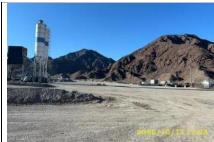
Фото 114. Лот 1. Производственная база. БСУ.
