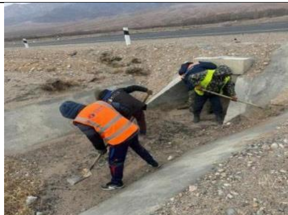
Фото 10. Очистка водопропускных труб.
