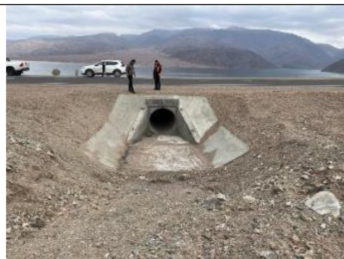
Фото 104. Лот 1. Очистка водопропускной трубы, км 33+869.
