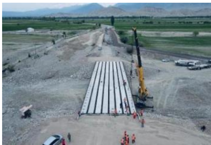
Фото 93. Лот 2. Фото 6. Строительство моста через р. Жоон-Арык на км. 65+410, монтаж плит.
