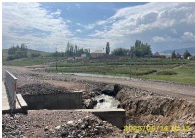
Фото 31. Лот 2. Мост км 86+261. р. Саздын-Суусу, объездная дорога.
