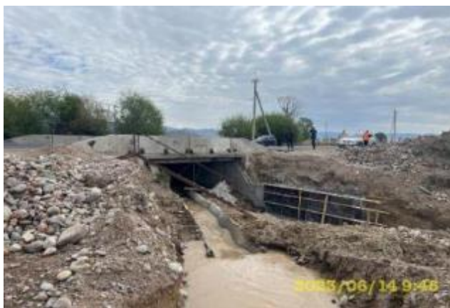
Фото 94. Лот 2. Мост р.Мукандын-Суусу, км. 68+040. Отсутствуют защитные мероприятия, предотвращающие попадание грунта в реку при производстве строительных работ.
