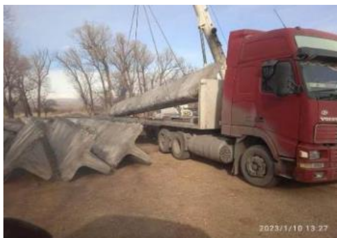
Фото 92. Лот 2. Вывоз демонтированных плит моста на км. 62+400
