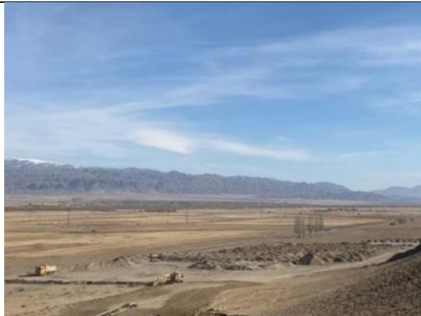
Фото 25. Отвал непригодного грунта на км. 80+900 в период складирования
