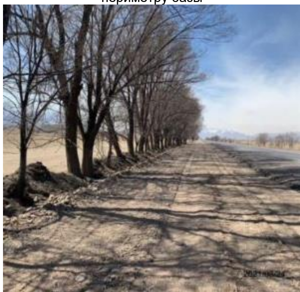
Фото 19 и 20. Обочины дороги с удаленным почвенным слоем
