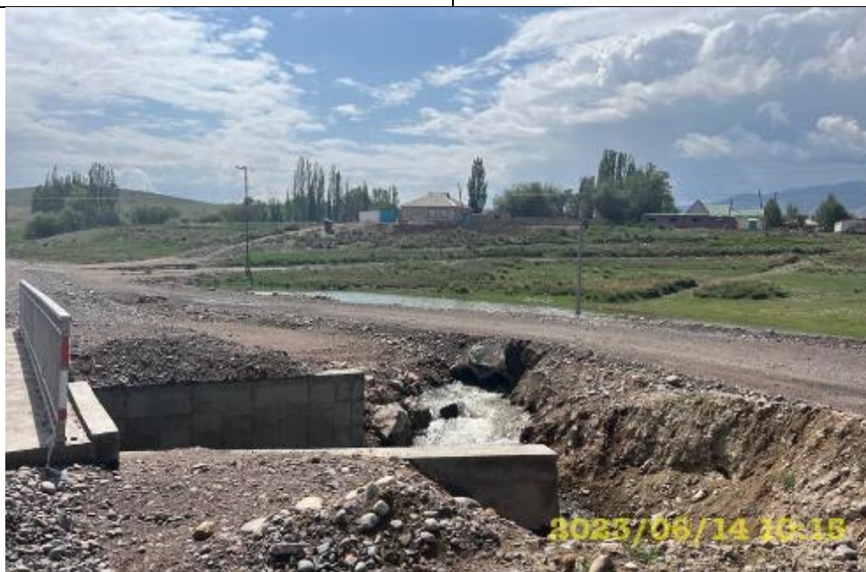
Фото 96. Лот 2. Мост км 86+261. р. Саздын-Суусу, объездная дорога
