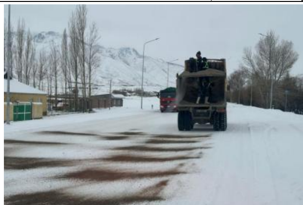
Фото 18, 19. Лот 2. Подсыпка инертного материала
