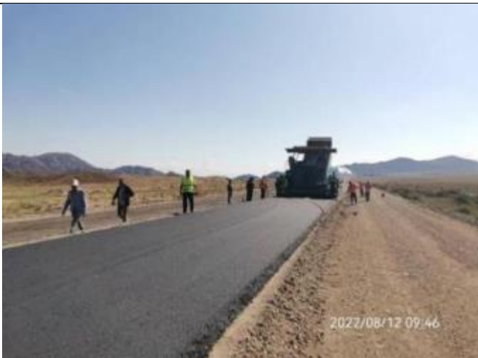
Фото 76. Лот 1. Укладка биндер слоя на км 17+230 - км 17+500.
