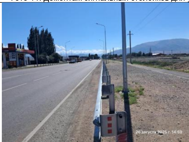
Фото 12, 13. Лот 1. Установка дополнительного ограждения для уличного освещения. Август 2025 г.
