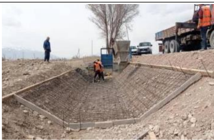
Фото 106. Лот 2. Заливка бетона для укрепления откоса км 64+860.
