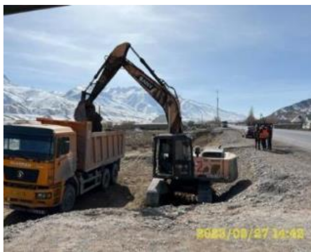
Фото 16. Лот 2. Снятие и вывоз ПРС с участка под тротуар
